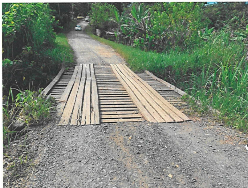
Foto 1- Atual travessia aérea existente no local.
